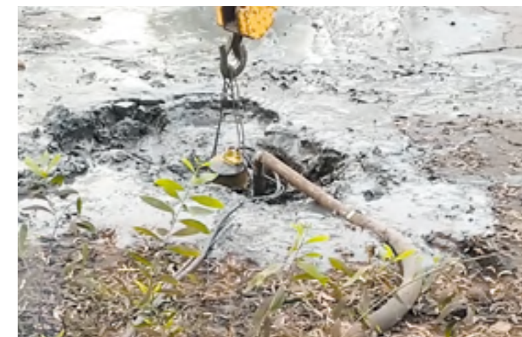
ZUMFA 4HD в процессе откачки шлама
