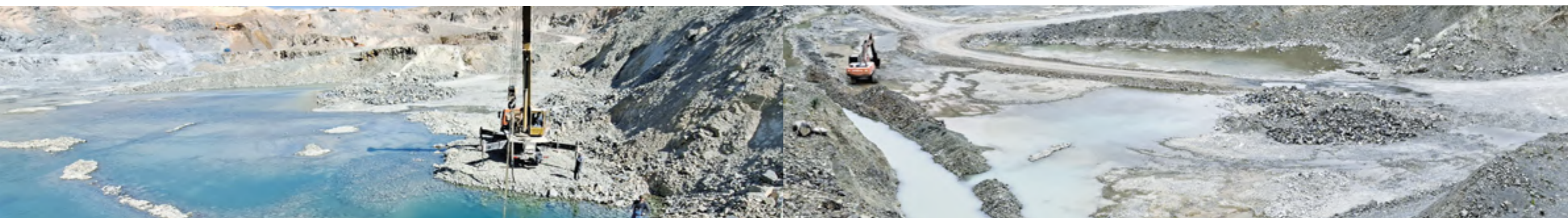
Дренаж на карьере, фото до установки насоса ZUMFA
